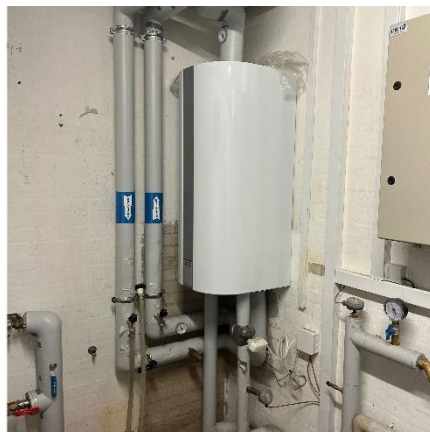
Varmtvandsbeholder
