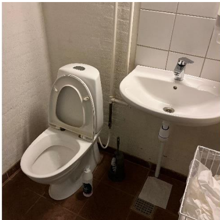
Toilet og vask i omklædning
