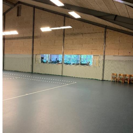
Pulastic belægning i hal
