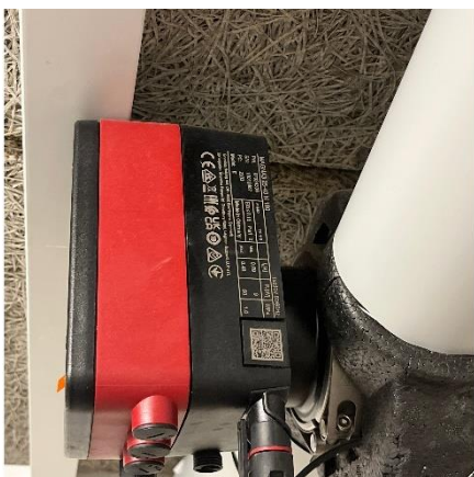
Cirkulationspumpe
