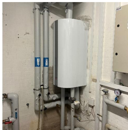
Varmtvandsbeholder
