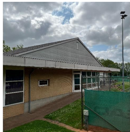
Ydervægskonstruktion i hal
