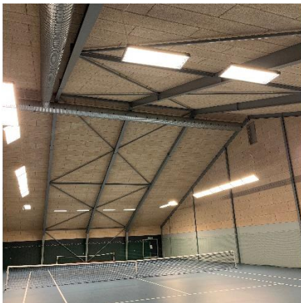
Hal belysning med kompaktlysrør og HF
