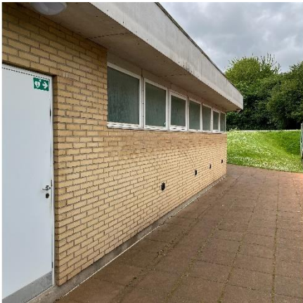
Flisebelægning rundt om tennisklub
