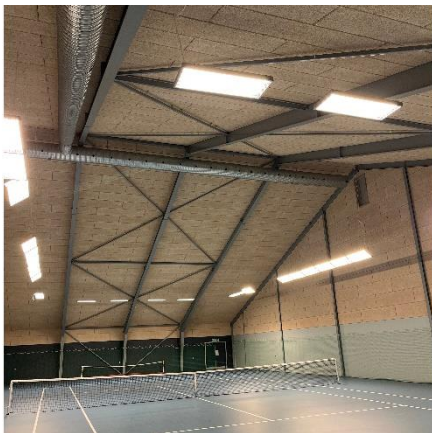
Hal belysning med kompaktlysrør og HF
