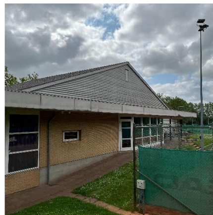
Ydervægskonstruktion i hal
