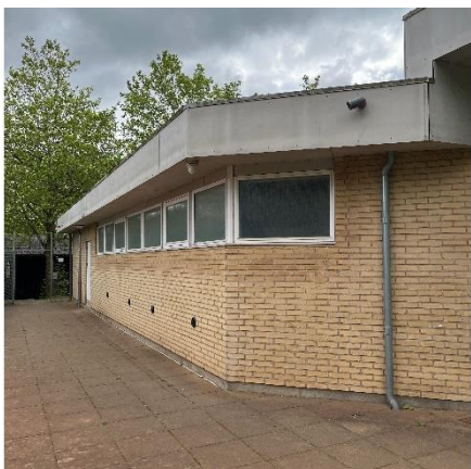
Vinduer i omklædning
