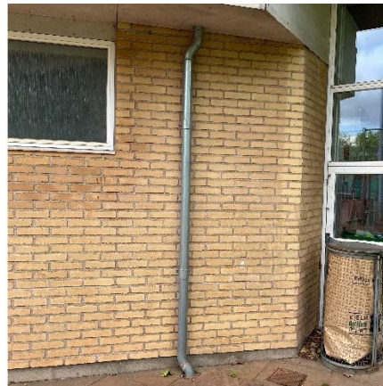
Nedløbsrør i zink
