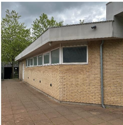
Vinduer i omklædning
