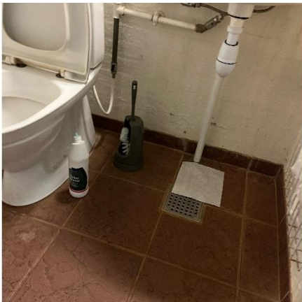
Afløbsrør i plast på toiletter
