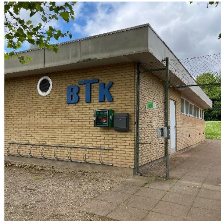
Hegn med alarminstallation ved indgang til BTK
