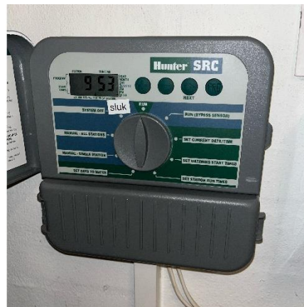
Automatik til vandingsanlæg
