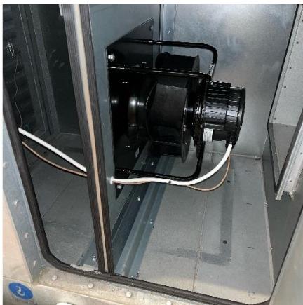
Centrifugalventilator fra 2022
