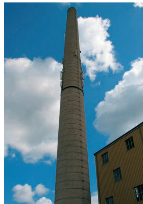
Den gamle dampkraftscentral med den markante skorsten.
