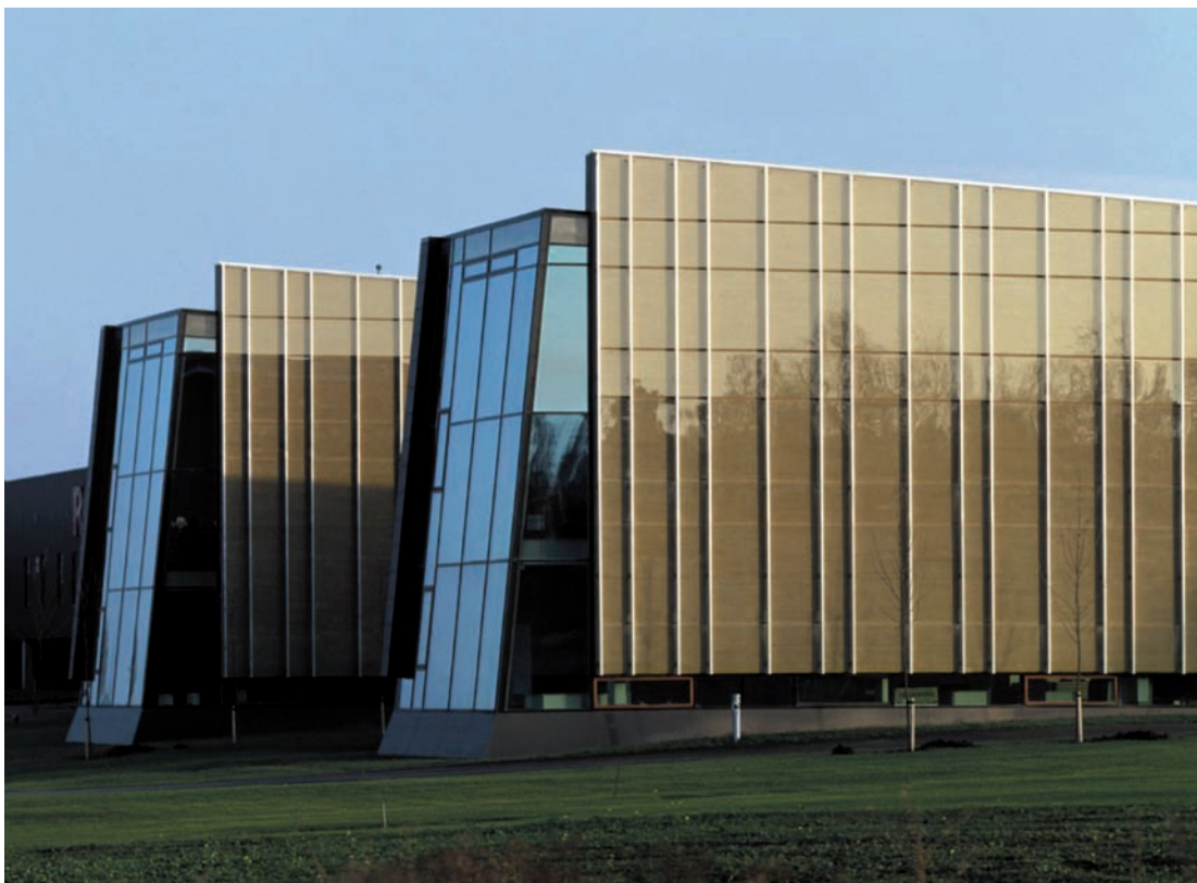
Virksomhed bygget som lavenergi byggei. Rockwools hovedsæde i Hedebyene. Foto: Rockwool.
