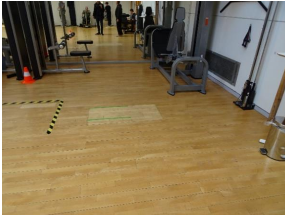
En af mange reparationer gulv i gymnastiksal
