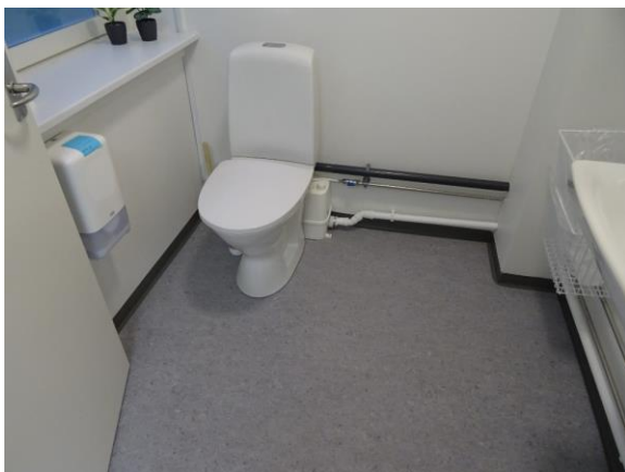
Afløbspumpe i kælder
