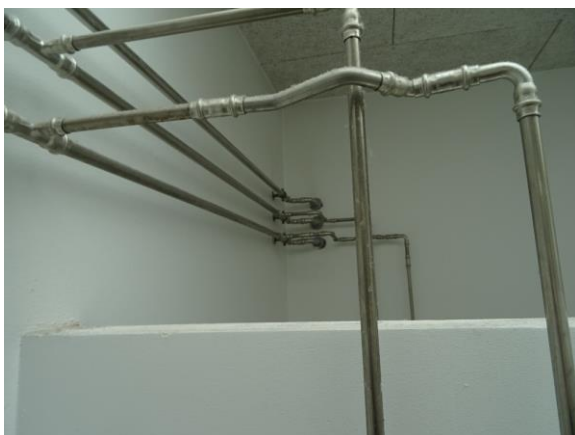
Varmtvand og cirkulation, uisoleret
