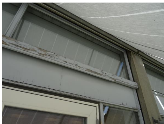
Termoruder i overparti. Nyt vindue monteret i gammel ramme.
