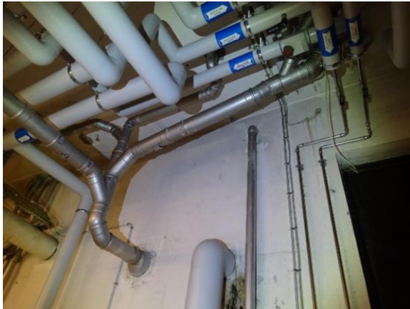
Afløb i kælder skiftet til rustfri
