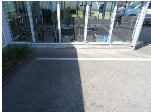
Sokkel skader pga. saltning omkring hovedindgang
