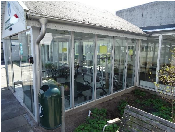
Vindfang, hovedindgang. To-lags og et-lags ruder
