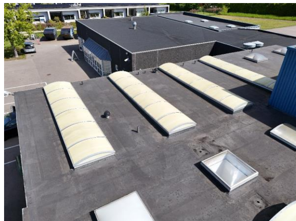
Tag over omklædning / behandlingsrum m flydende membran
