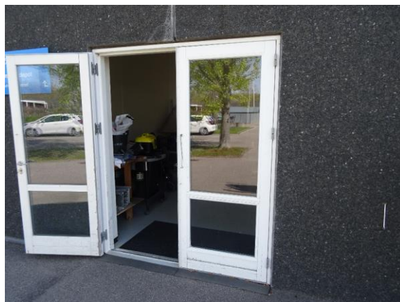
Trædør i bygning fra 2003
