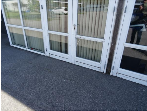
Trædør og vinduer i karnap fra 2003
