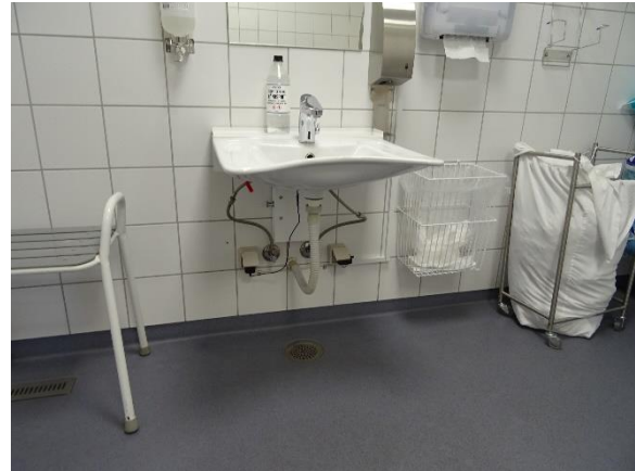
Berøringsfrit armatur
