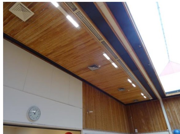
Forskallings loft i gymnastik
