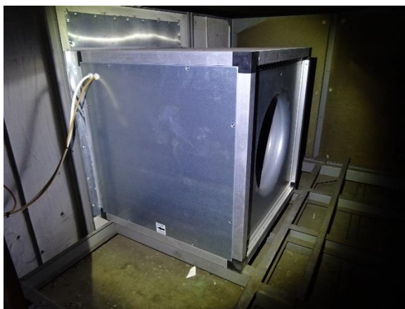
Udskiftet ventilator
