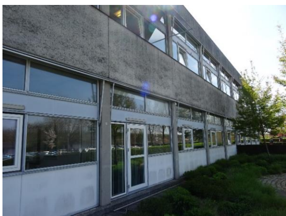
Nye facadedøre i gammel facade
