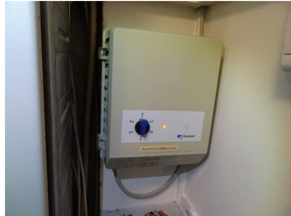
Styring udsugning vestbygninger
