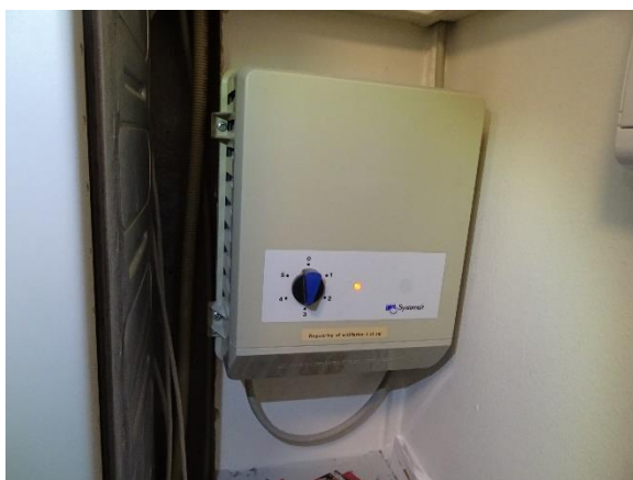
Manuel styring for udsugning af en etage
