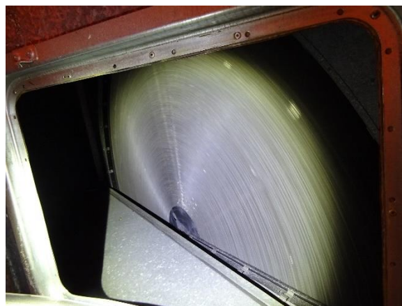
Rotorveksler for ventilering af omklædning og behandling
