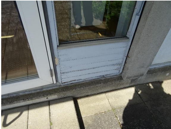
Uisoleret brystning i massiv træ
