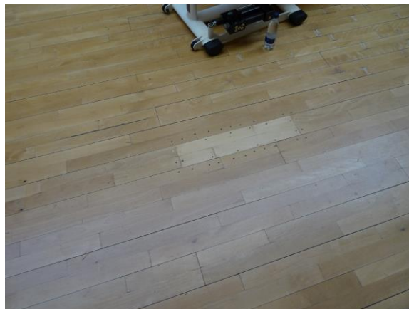
En af mange reparationer gulv i gymnastiksal
