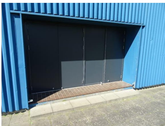
Nyere udgangsdør fra gymnastikbygning
