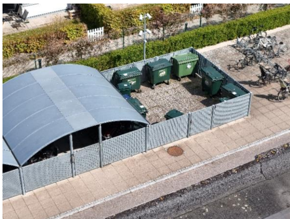
Cykeloverdækning og affaldsgård fra 2017
