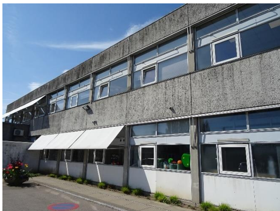
Oplukkelige vinduer er 3-lags energiruder. Omkringsiddende er termoruder
