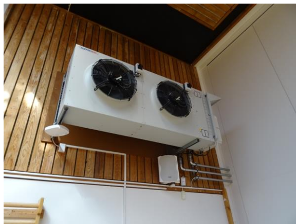
Tørkøler anvendt som varmeblæser i gymnastiksal
