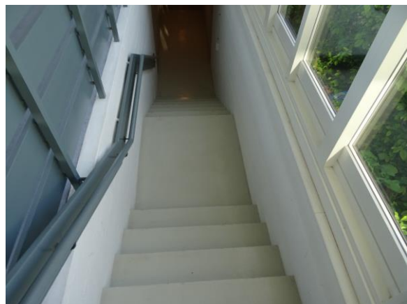
Betontrappe til kælder
