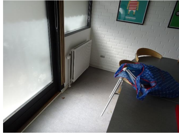
Radiator forsynet fra krybekælder
