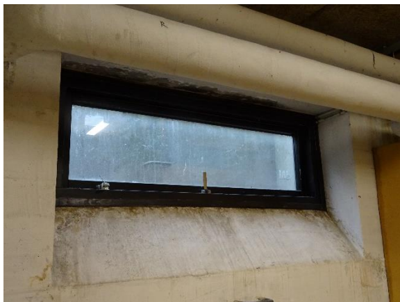
Er Massiv beton kælderydervæg
