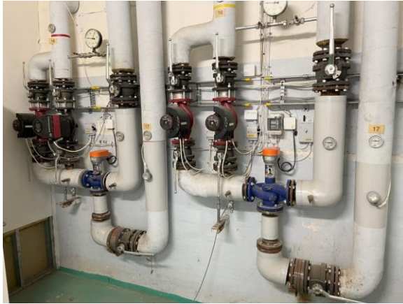
Nyere Magna pumper der ikke giver mening at udskifte før nedbrud.
