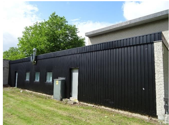
Ståltrapezfacade øst for hallen sydvendt
