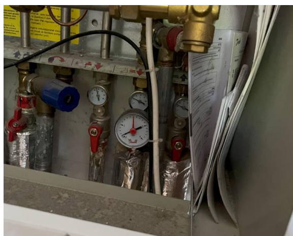
Decentral varmeinstallation stod tæt på trykløst og pumpe kaviterede (luft)
