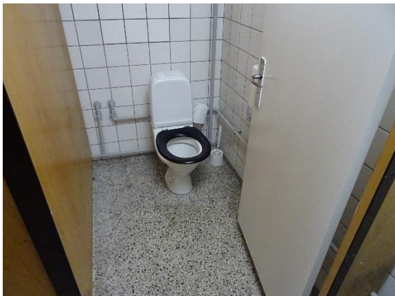
Ældre toilet i kælder
