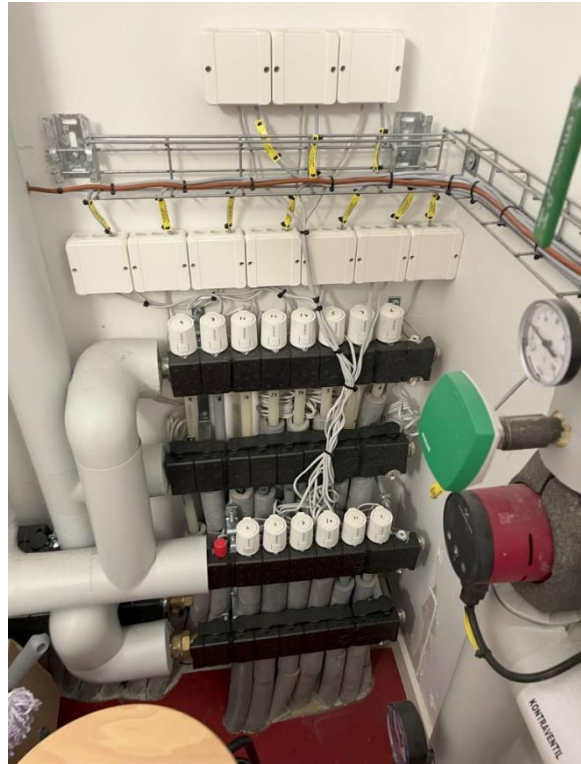
Gulvvarmeanlæg i ny SFO
