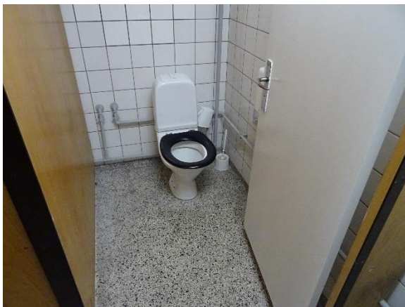
Ældre toilet i kælder
