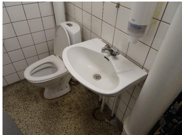
Oprindelig håndvask og ældre armatur, toilet skiftet
