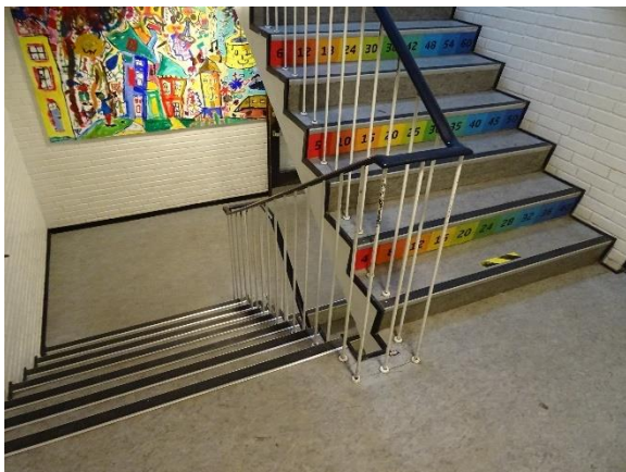
Trappe i vest bygning
