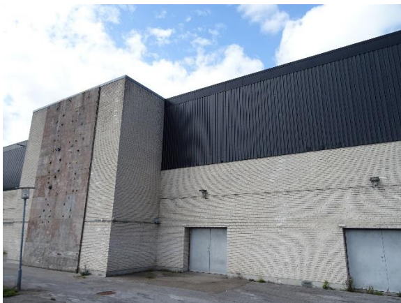
Murværk og ståltrapezfacade hallen
