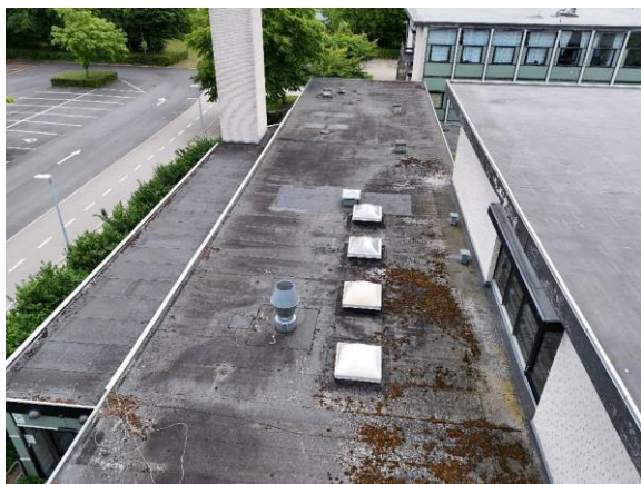
Tag nord for skolen og tilbygning omkring skorsten fra 2008.
