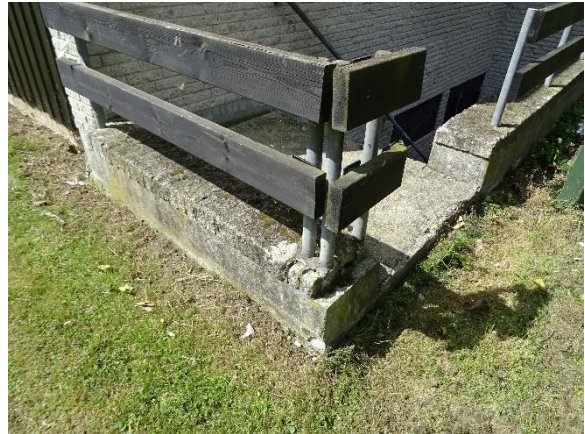
Rulleskifte ved trappe
