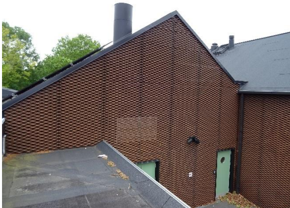
Profileret cortenstål
