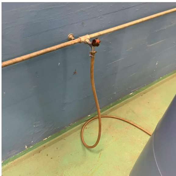
Påfyldning af varmeanlæg fra varmtvandshane
