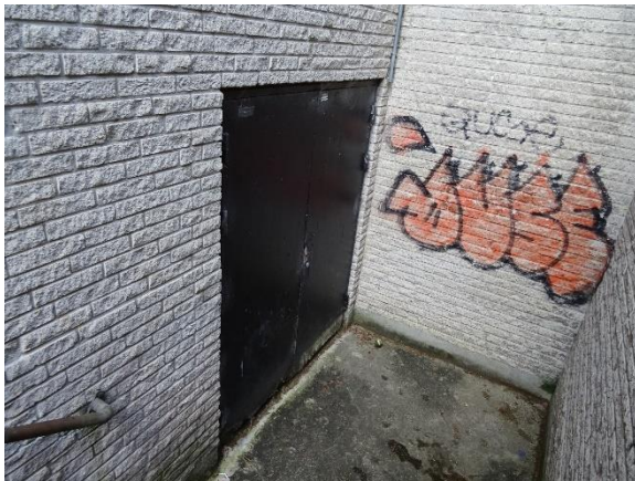
Dobeltdør til kælder sydøst
