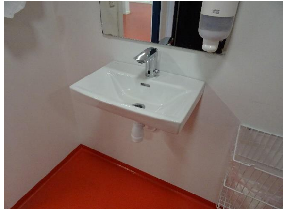
Vask med berøringsfrit armatur på batteri
