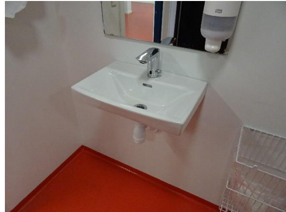
Vask med berøringsfrit armatur på batteri
