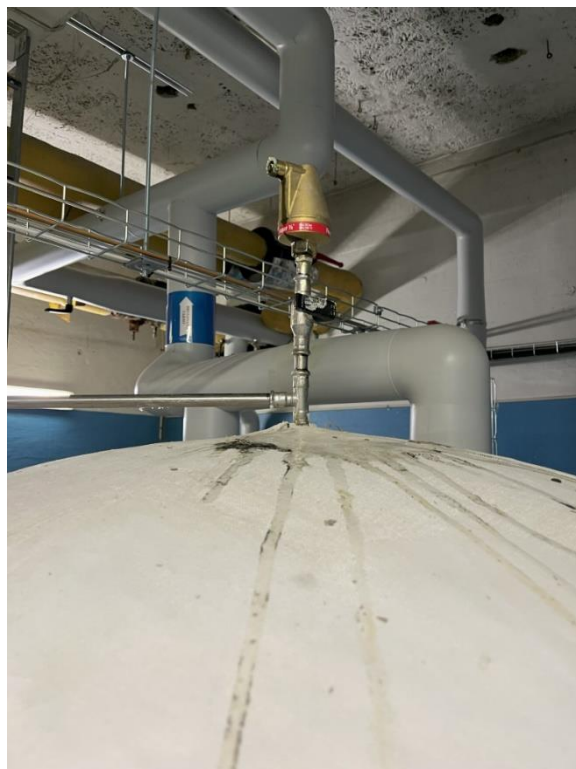
Afgang fra varmtvandsbeholder. Rør generelt godt isoleret.
