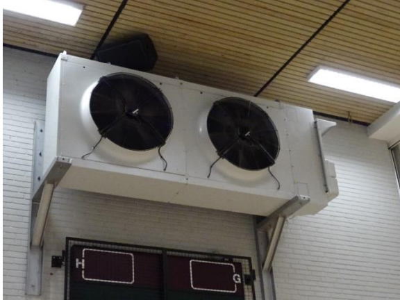
Varme via tørkøler i sportshal
