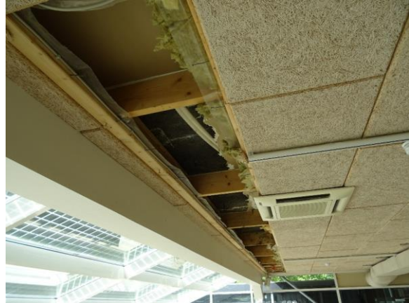
Blotlagt loftskonstruktion
