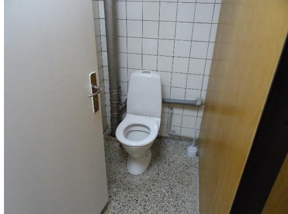
Faldstammer i kælder skiftet til rustfast
