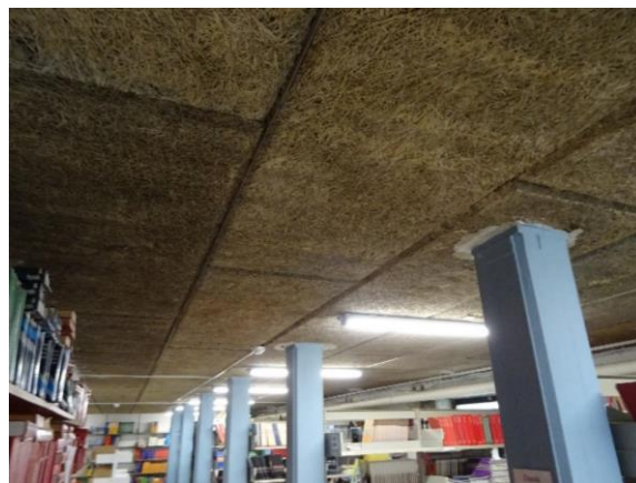
Træbetonloft bogkælder
