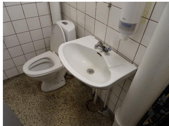
Oprindelig håndvask og ældre armatur, toilet skiftet
