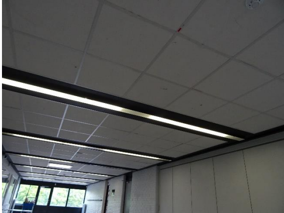
Retrofit med LED rør i gang
