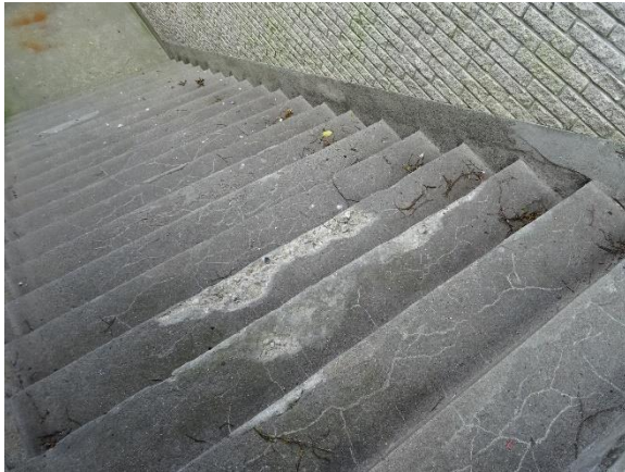
Trappe til varmecentral
