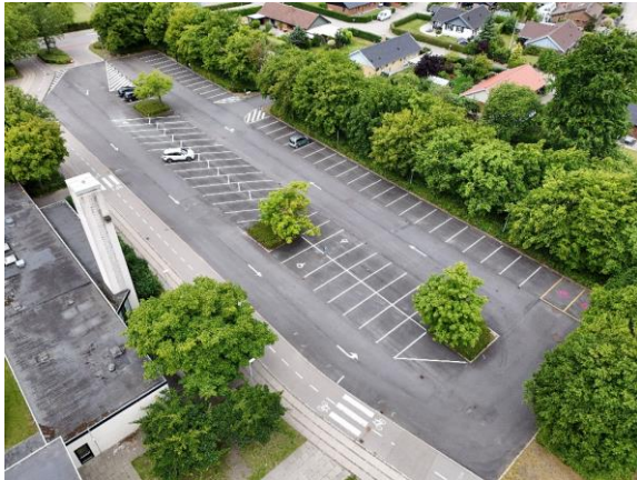
Parkeringsplads med nyere asfalt
