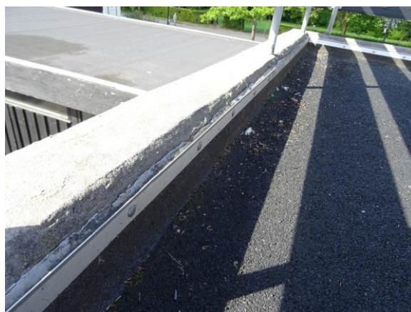
Fugeskinne og fuge langs tagkant
