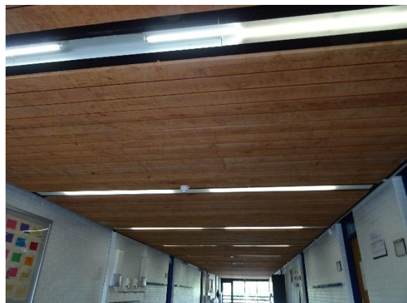
Forskallingsbrædder loft i gang med LED rør i gl. armatur
