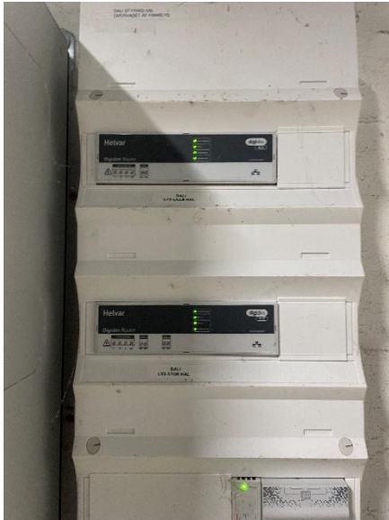
Dali styring for motionshals belysningen
