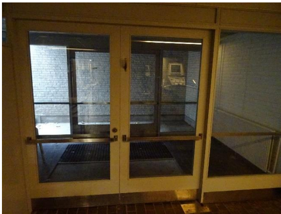
Kælder vindfang nord med 1 lag glas
