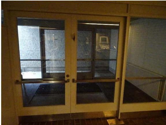
Vindfang til kælder
