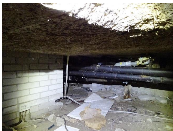
Decentral varmeinstallation stod tæt på trykløst og pumpe kaviterede (luft)
