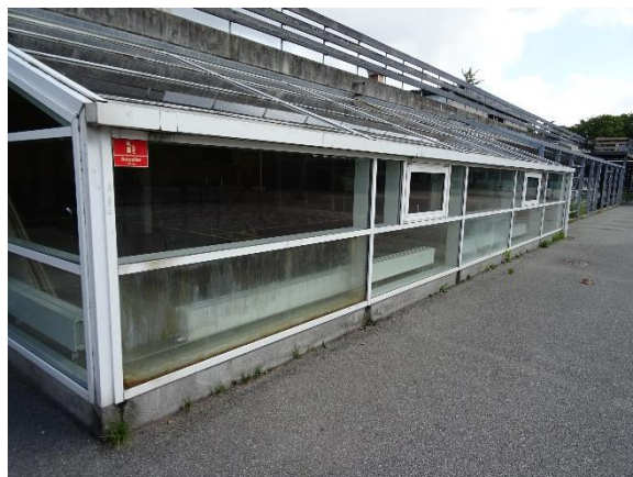
Tilbygning fra 2005, energiruder to-lags
