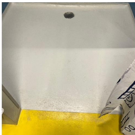
G5 Epoxygulv i omklædning
