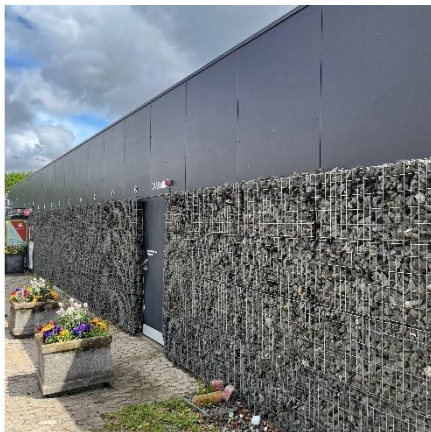
G6 Eternitfacade med udv. gabion
