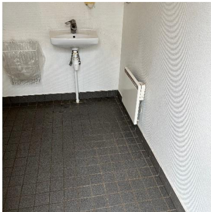
G5 Flisegulv på toilet
