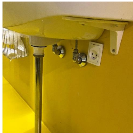
G6 Afløbsrør i rustfrit stålør
