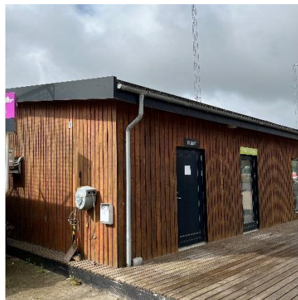
G5 Døre i undervisningsbygning
