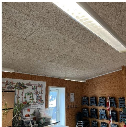
G5 T5 rør med HF
