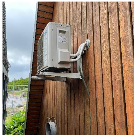
G5 Udedel luft/luft varmepumpe
