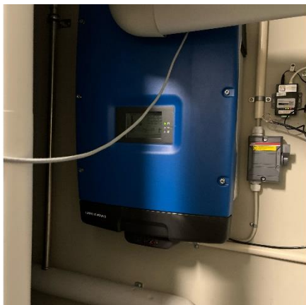
G6 Inverter til hybridanlæg
