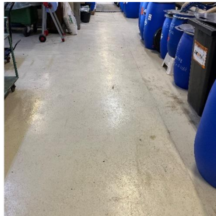
G6 Epoxygulv i sortering
