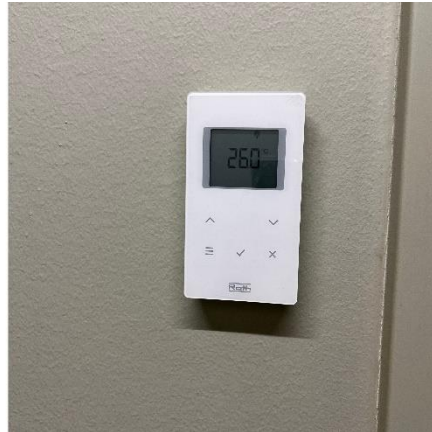
G6 Rumtermostat til gulvvarme
