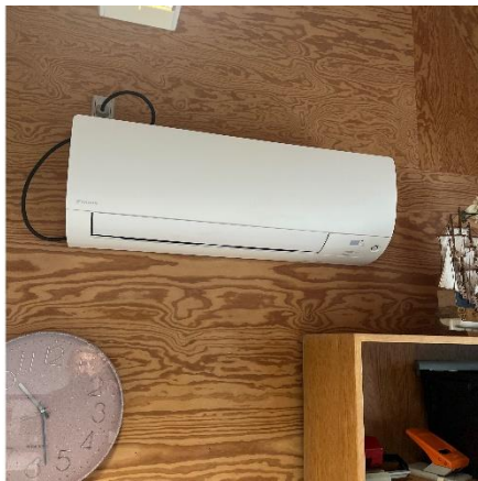
G5 Luft/luft varmepumpe
