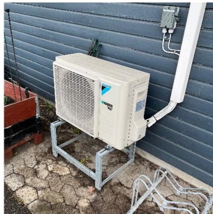
G3 Udedel til luft/luft varmepumpe
