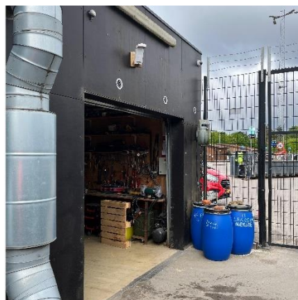
G6 Port ved bagfacade
