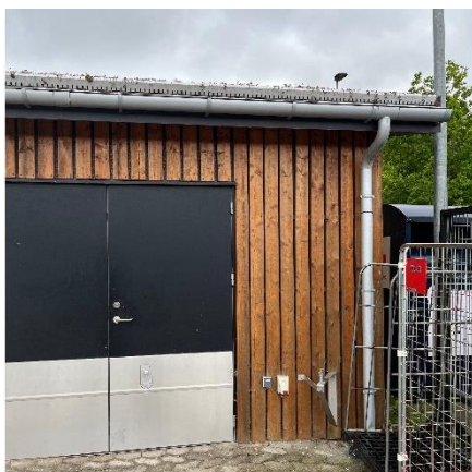
G7 Tagrende og nedløbsrør
