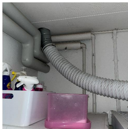
G3 Tilslutningsrør til vaskemaskine
