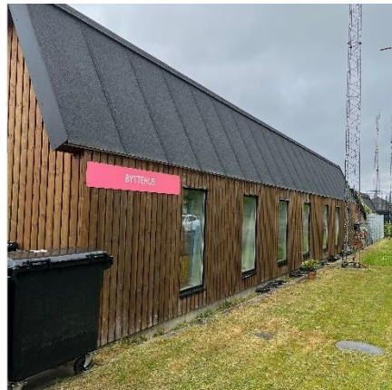
G7 Vinduesfacade i byttehus
