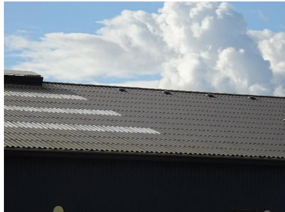
bølgeplader med bånd i ovenlysplader
