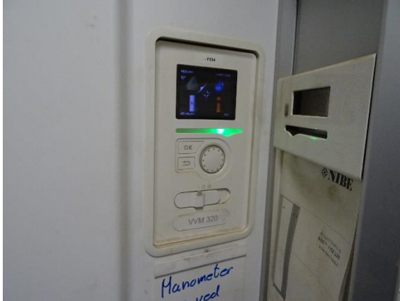
Betjening af varmepumpe
