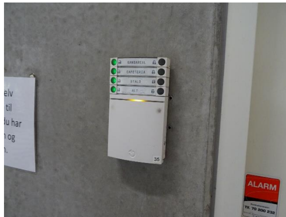
Kodetastatur for indbrudsalarm
