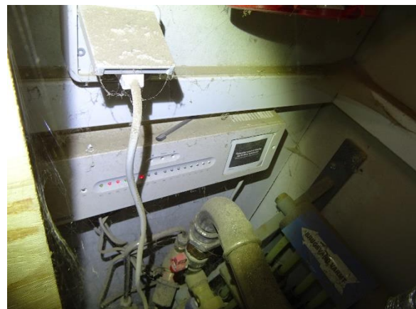
Gulvvarmestyring med røde lamper og indikation af fejl på de fleste kredse
