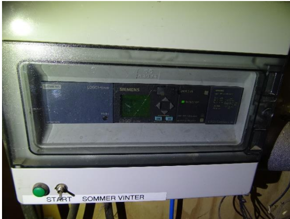
styring for vandingsanlæg
