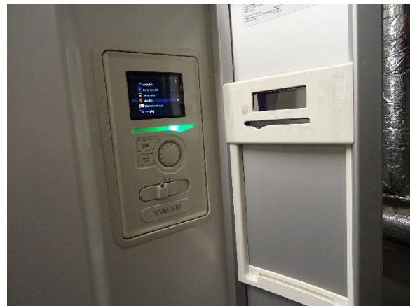
Varmepumpe betjeningspanel
