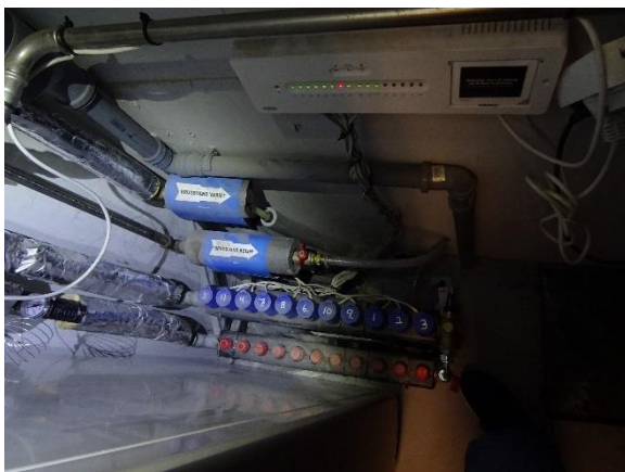
Telestater for gulvvarmeshunte.
