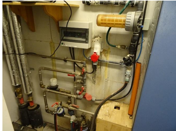
Forsyningsrør til vandingsanlæg
