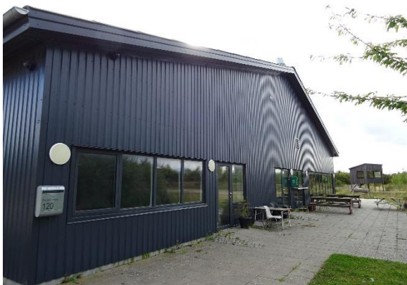
Vinduer i gavlfacade mod vest
