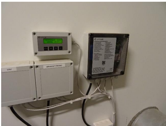
Brandsikringsautomatik ventilation
