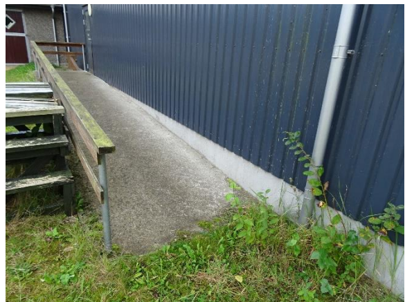
Sokkel ved rampe til hal 1
