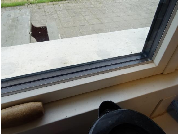
3-lags rude i vindue
