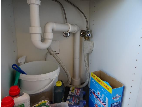
Afløb under køkkenvask
