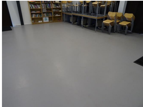
Epoxygulv i grupperum
