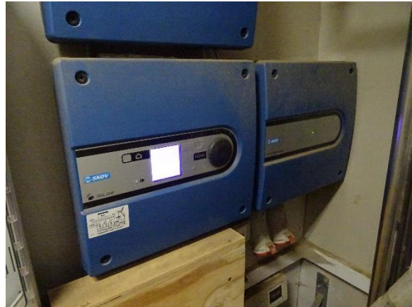
Ventilations styring i staldbygning
