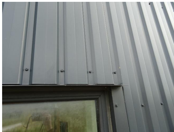
Facadebeklædning over vindue
