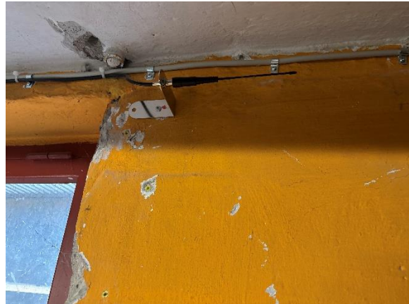
Kælder fundament vægge
