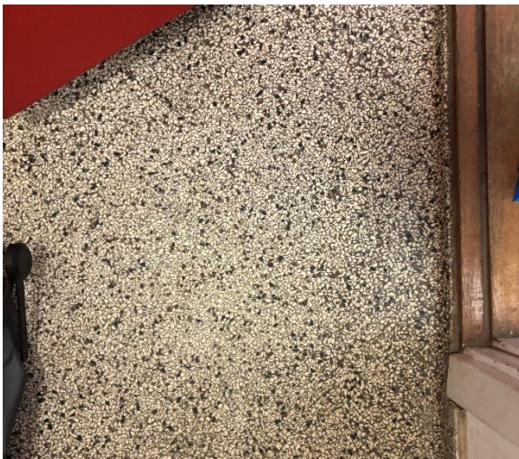
Terrazzo i toiletter og vaskerum
