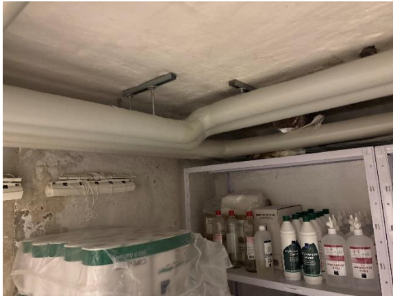
Kælder fundament vægge
