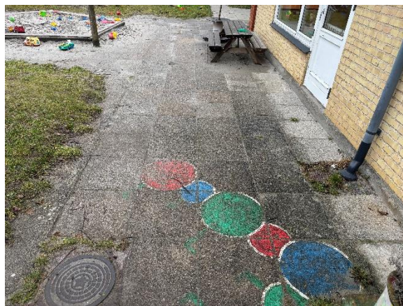
Belægning udført i betonfliser
