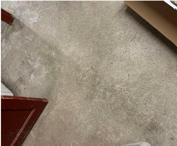
Kældergulv støbt beton
