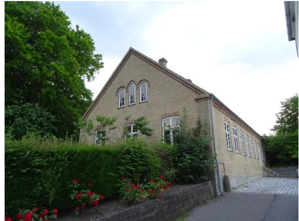
Bygning 1 fra 1900 set fra sydvest
