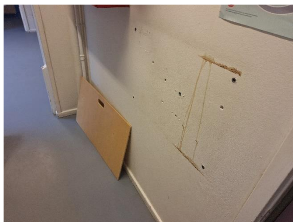
Bærende konstruktionsvægge muret op
