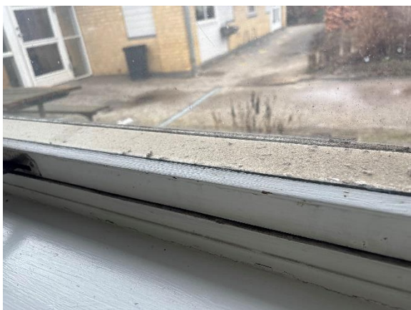
1+1 lag vinduer fra 1954
