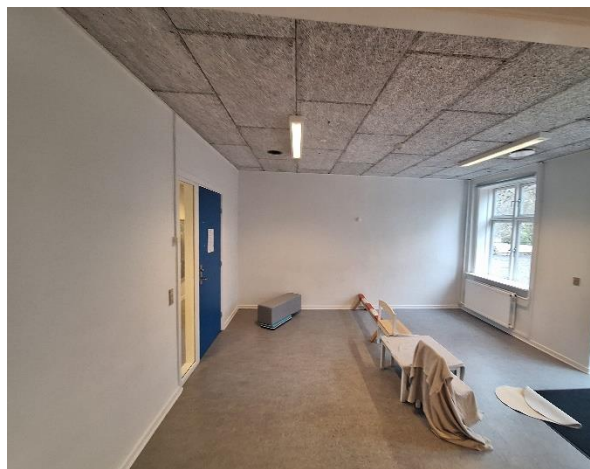
Indvendig væg i gips.
