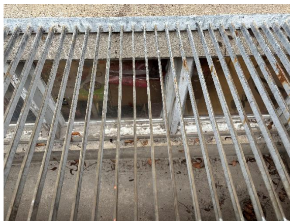
Vinduer med 1 lag glas i kælder
