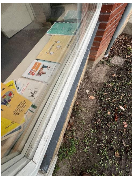
1+1 lag vinduer fra 1954
