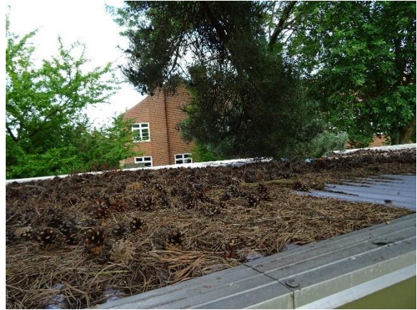
Massivt løvfald på plasttag
