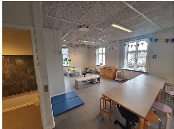
Lydlofter i træbeton. Opsat i skinnerne system.
