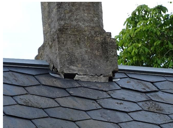
Mørtelkant på skorsten mod skifertagflade
