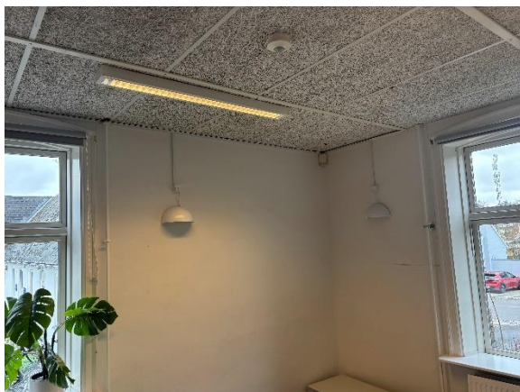
Konventionelt armatur og bevægelsesmelder
