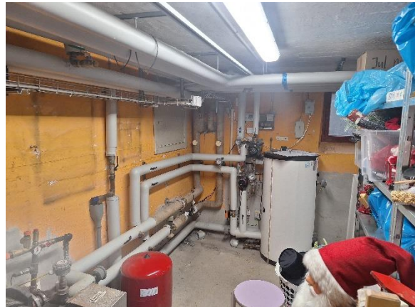
Pladsstøbte beton kælderydervægge
