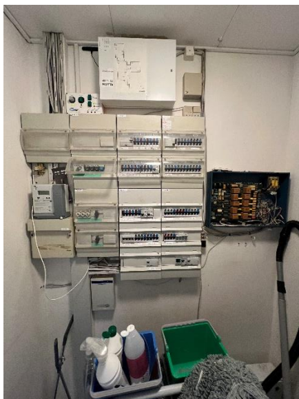
Hovedtavle, alarm, energiovervågning og ventilatorstyring
