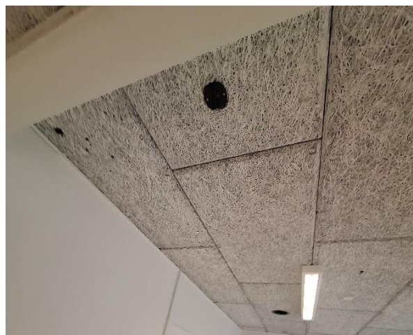
Lydlofter i træbeton. Direkte montage.
