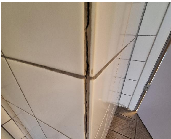
Flisevægge i toilet rum
