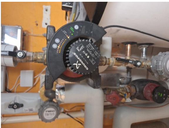
Brugsvandspumpe
