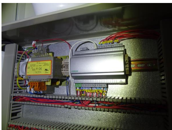
Controller for anlæg på tag
