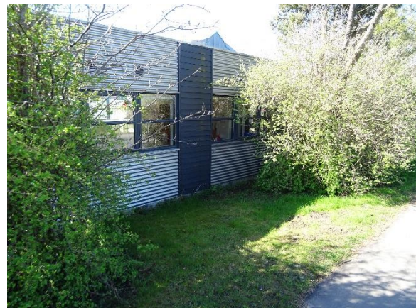
Vinduer med energiruder fra 2014, pavillon 2016
