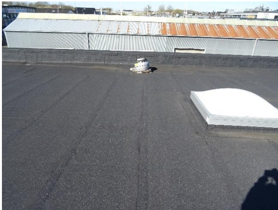
Henkastet tagventilator på tag
