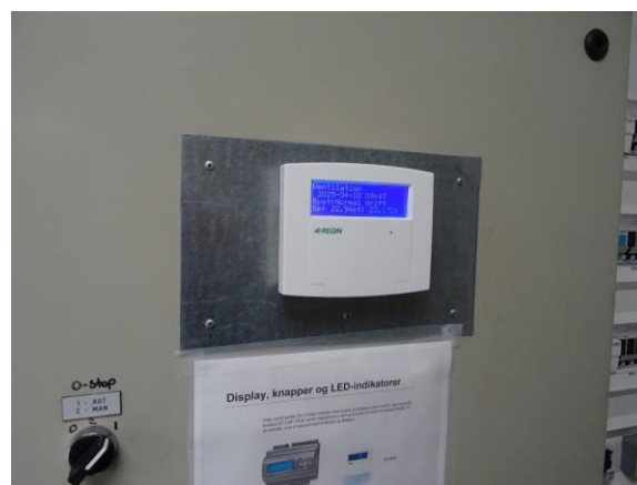
Betjeningspanel for anlæg på tag
