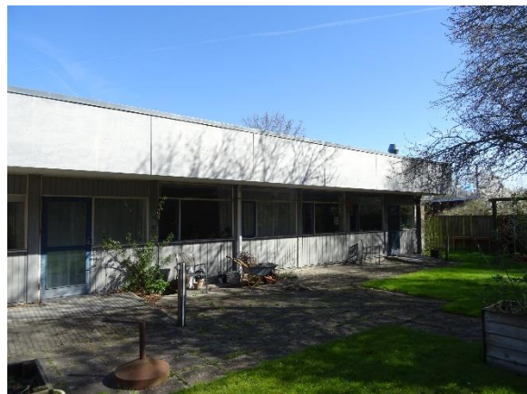
Døre med termorude mod syd
