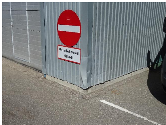
Påkørselsskade på lager, en af flere
