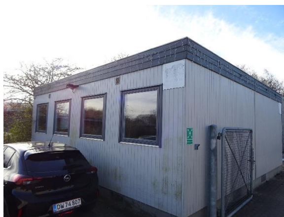
Vinduer fra 2012 i pavillon
