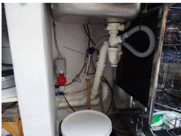
Afløbsinstallation under vask i tekøkken
