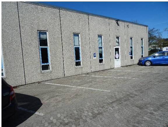
Betonsandwichelementer mod øst
