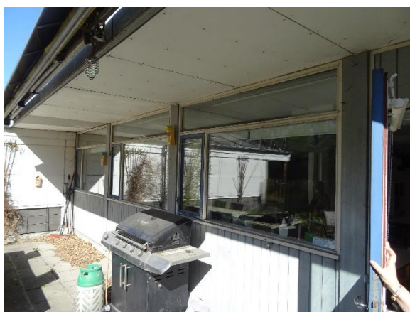
Vinduer fra 1972 med termoruder
