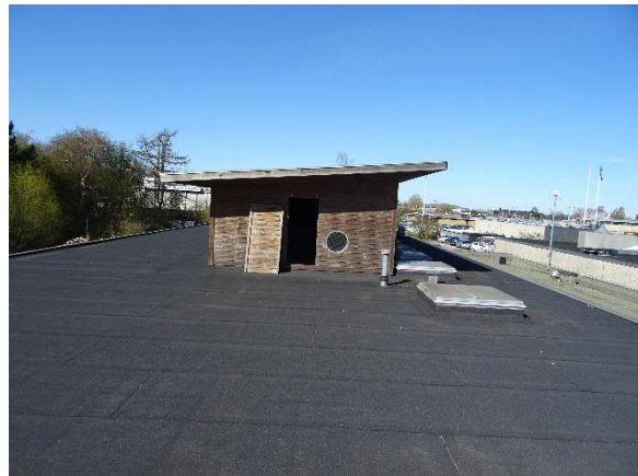
Sydfløj og ventilationshus
