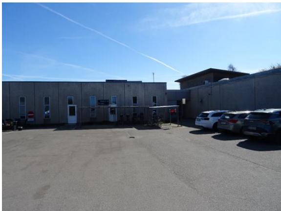
Asfalt på parkering vest
