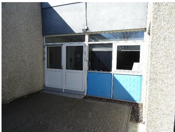
Ny indgangsdør fra øst
