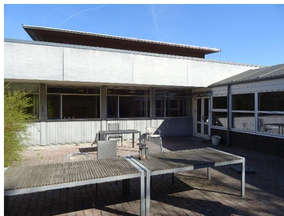
Let facade mod syd ved kantine tilbygning fra 1998
