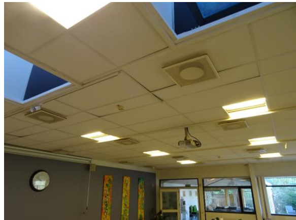
Glamox armaturer med kompaktlysstofrør
