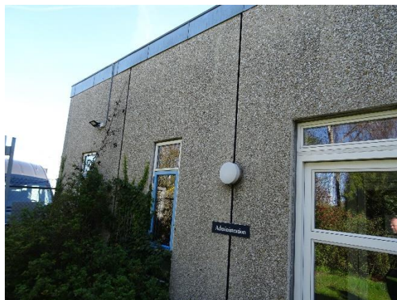
Vinduer fra 2002 tilgroet af vedbend
