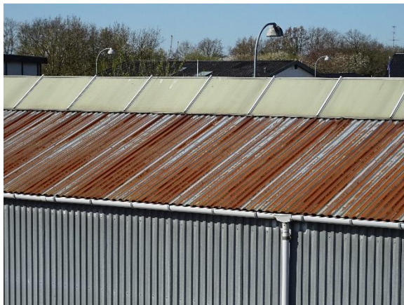
Ståltrapeztag på lagerbygning
