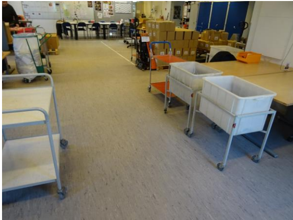
Ældre linoleum i værksted
