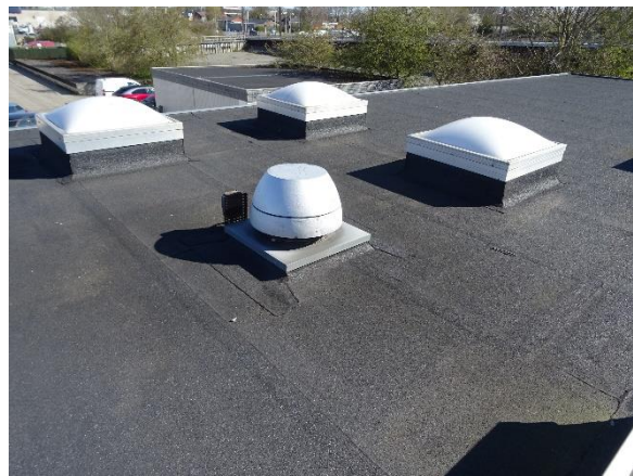
Tagventilator, medium alder, stor spredning på aldre
