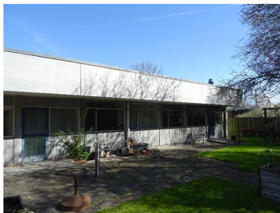
Døre med termorude mod syd
