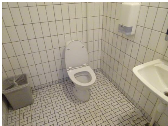
Toilet, ældre håndvask og overflader
