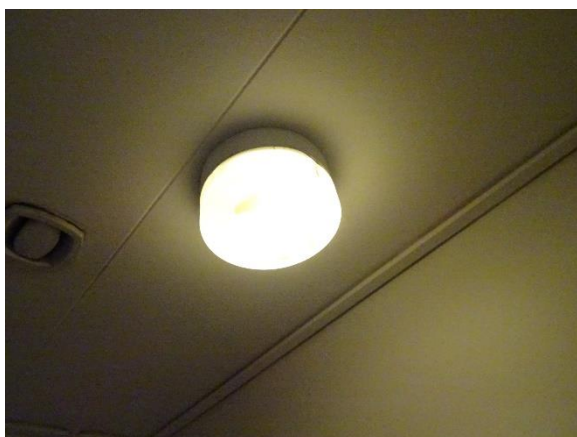
Kompaktlysstofrør, toilet
