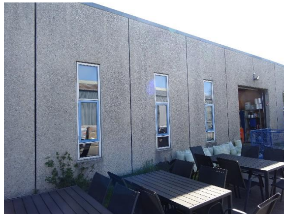
Betonsandwichelementer mod vest
