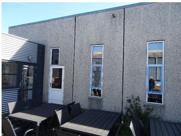
Vinduer og før fra renovering 2002
