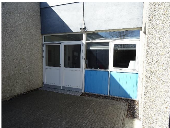
Ny indgangsdør fra øst
