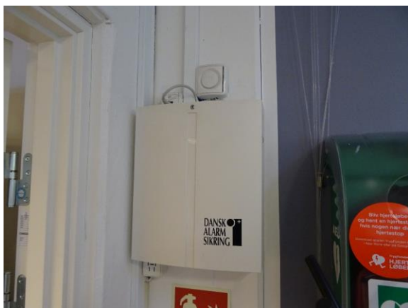
AIA indbrudsalarm central med fastnet
