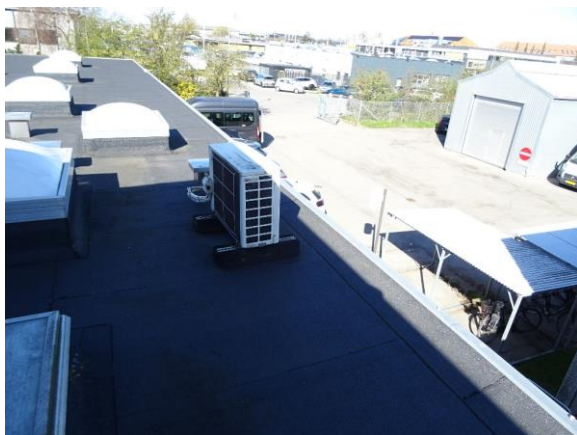
Kondensator for splitanlæg
