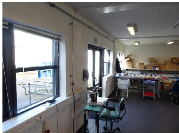
Ubenyttede trykluftrør i værksted
