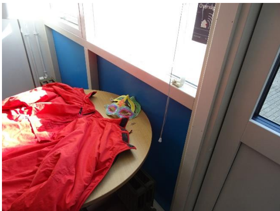
Brystning med 20-25 mm isolering v. indgang
