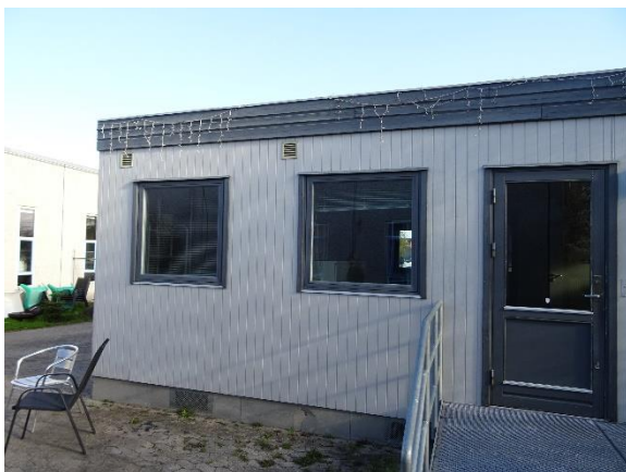
Pavillon vinduer med 3-lags ruder 2012
