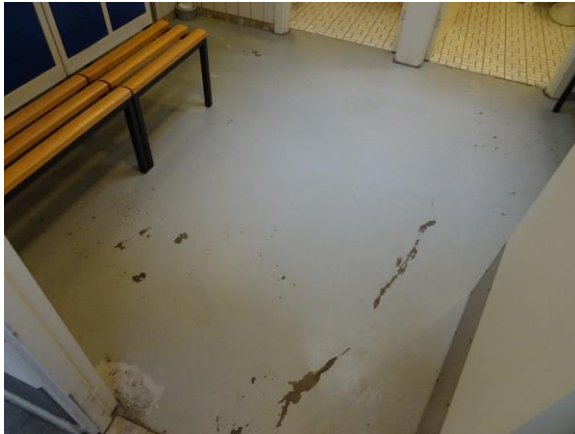
Toilet/omklædning fra oprindelige værksted
