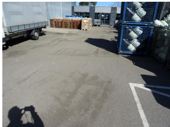
Asfalt plads vest
