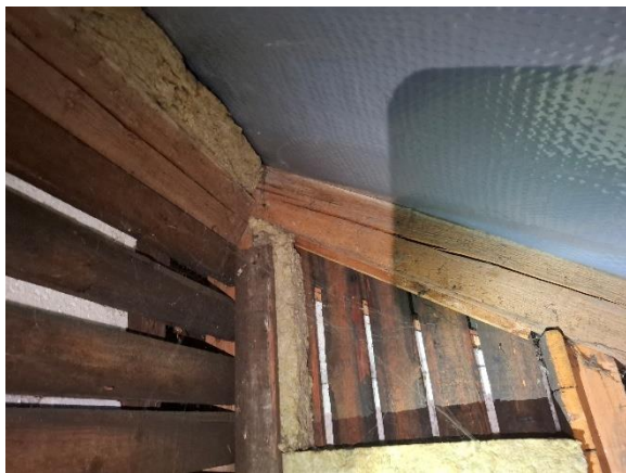
Skunkvægge isoleret med polystyrenplader
