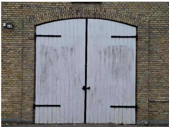
Bygning 1 – Port i vestvendt gavl
