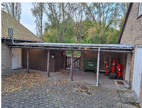
Overdækning mellem bygninger
