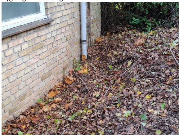
Bygning 1 – Bladbunke ligger op ad facaden mod sydøst.
