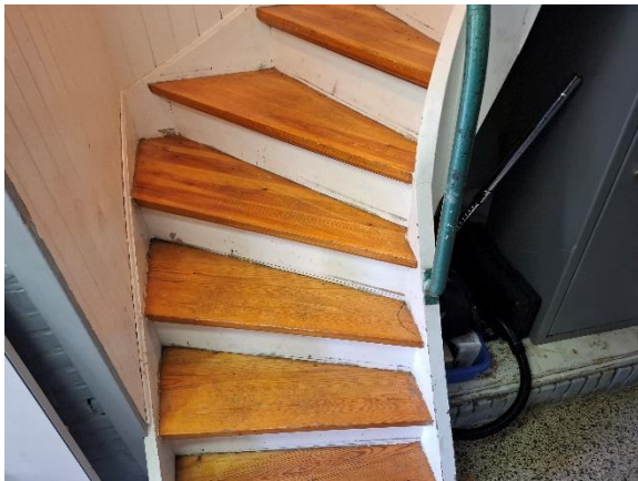
Bygning 2 – trappe til 1. sal
