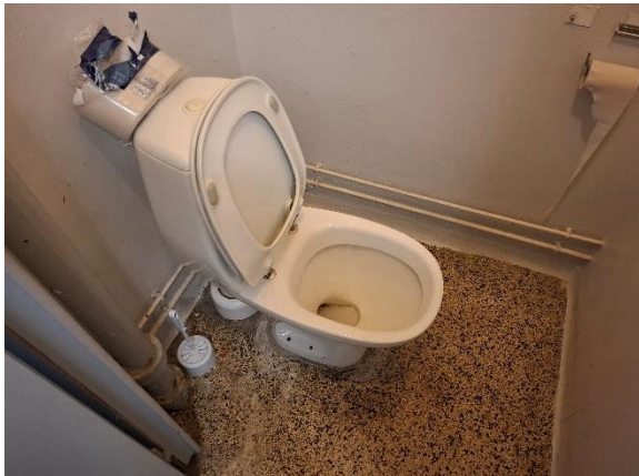
Toilet med 1 skyl
