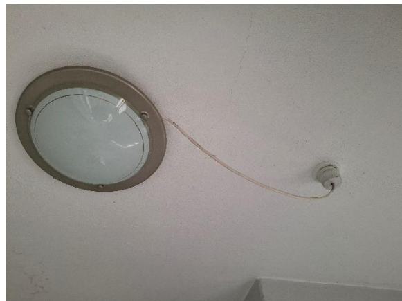
Bygning 2 – Loftslampe i toilettrum
