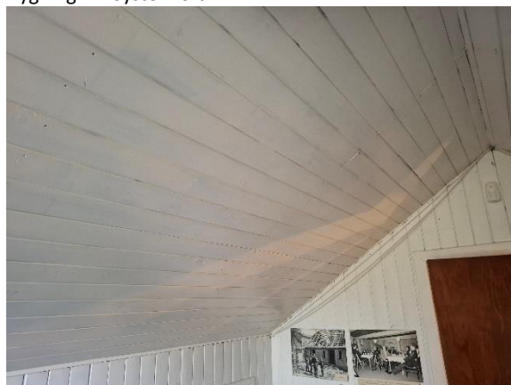
Bygning 2 – Loft- og vægbeklædning på 1. sal.
