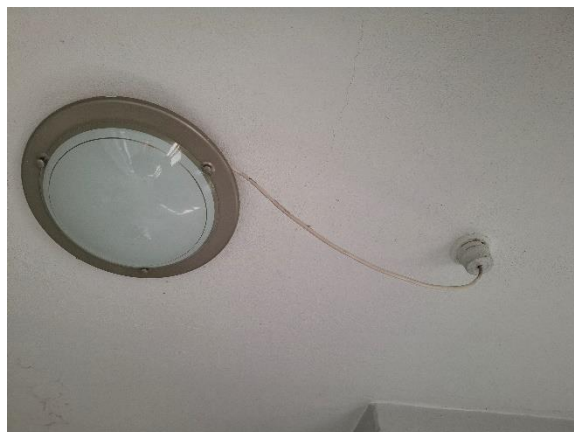
Bygning 2 – Loftslampe i toilettrum
