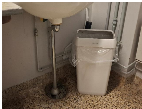
Bygning 2 – Gulvafløb i terrazzogulv
