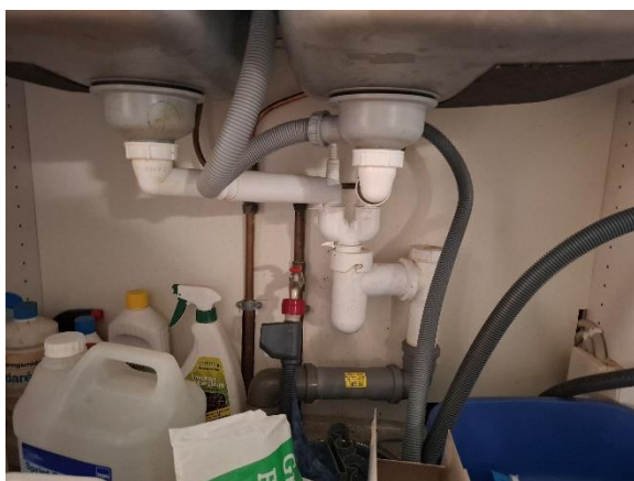
Bygning 1 – Afløb under køkkenvask
