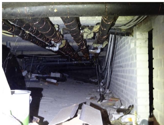
Afløbsrør i krybekælder skiftet til plast
