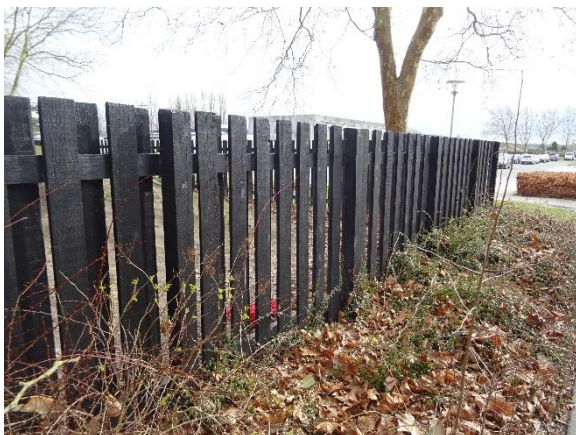
Perimeter plankeværk i træ
