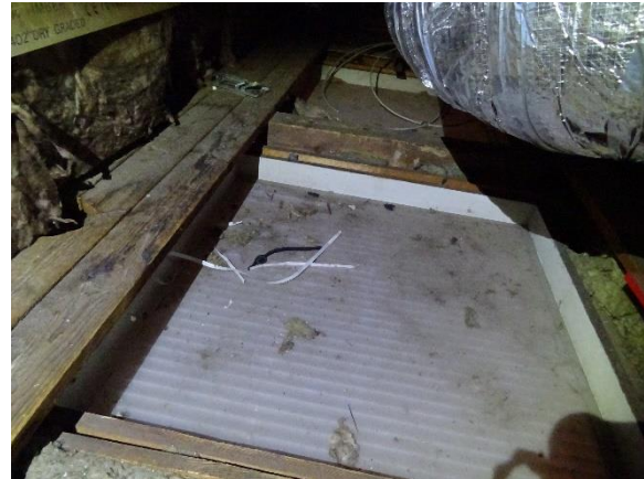
Termoplastplade mellem loft og gang
