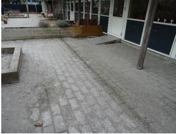
Betonsten belægning legeplads
