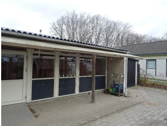
Vinduer fra 2010 mod syd, to-lags energirude
