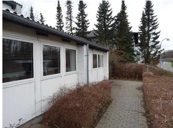
Vinduer mod nord tre-lags energirude
