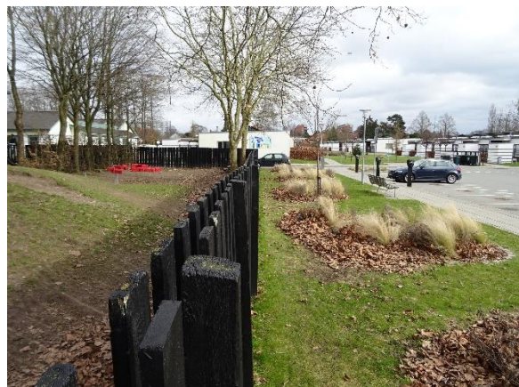
Stolper og brædder med udsat endetræ
