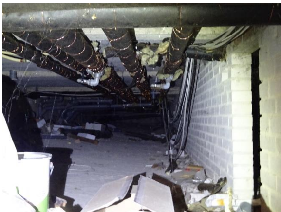
Krybekælder med rørføring
