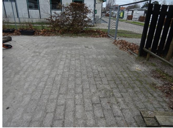
Betonsten belægning legeplads
