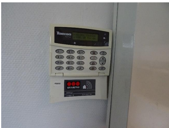
Kodetastatur for alarmanlæg
