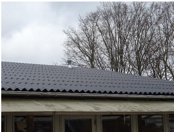
Nyrenoveret tag med bølgeplader mod syd
