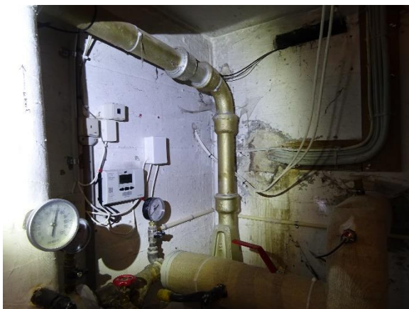
Et oprindeligt afløbsrør i støbejern
