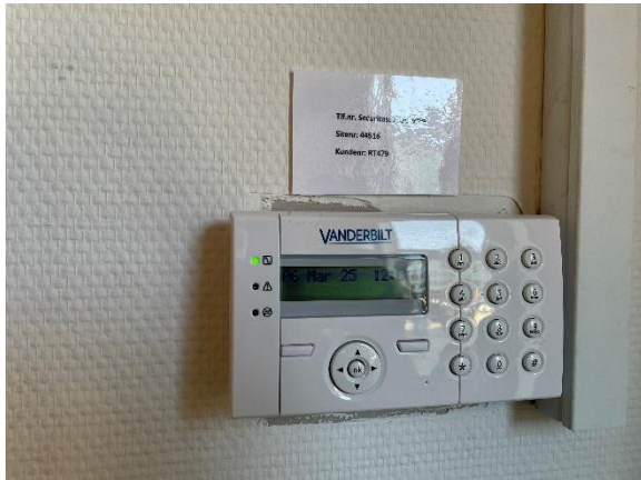
Kodetastatur til alarm
