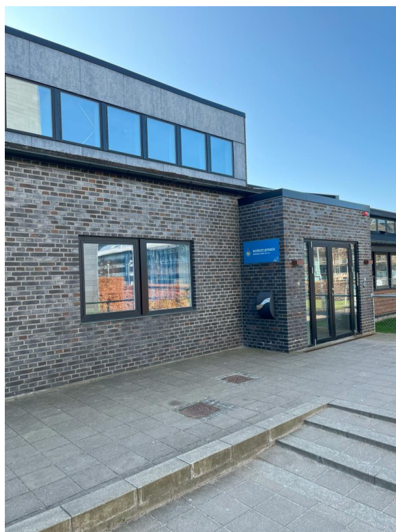
Facade ved indgang
