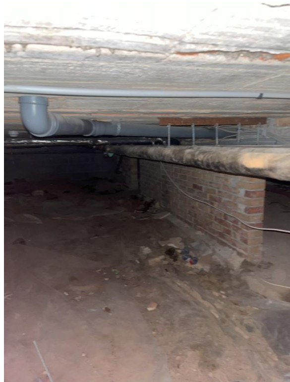
Den stabiliserende tegl mur
