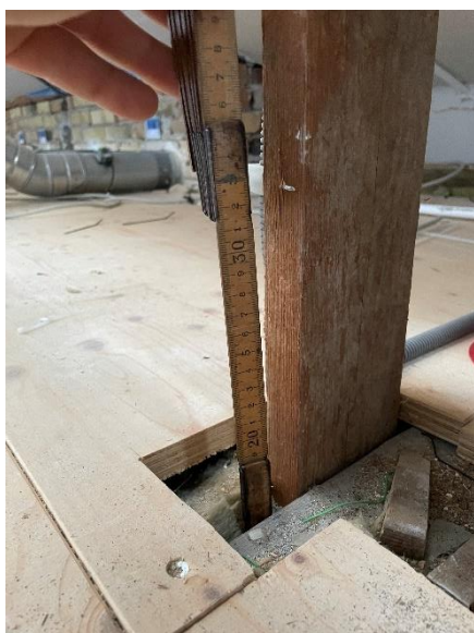
Måling af isoleringstykkelse
