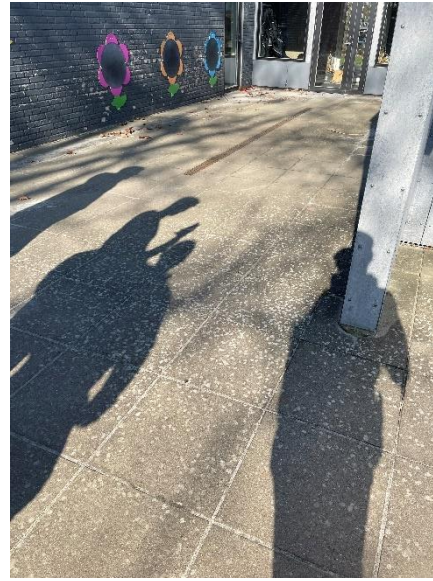
Flisebelægning omkring bygningen
