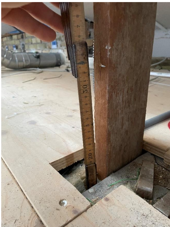
150 mm isolering på loft over gang
