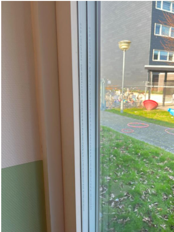
Vinduer mod indgang fra 2016
