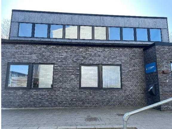
Ny ydervæg ud mod parkeringsplads
