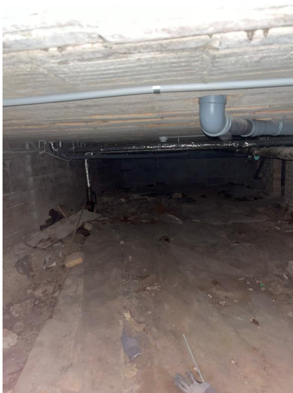
Isolering på underside af krybekælderdek
