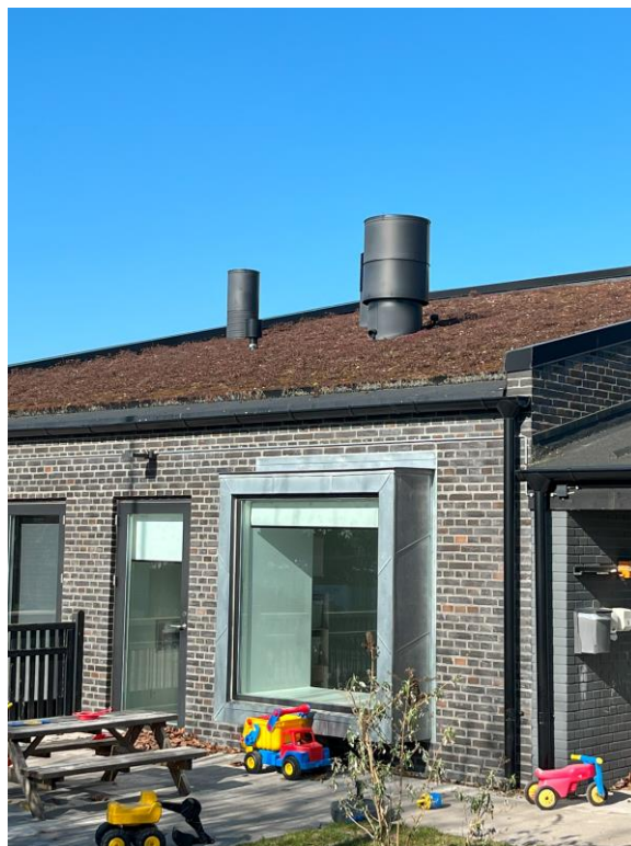
Sedum tag på midter bygning
