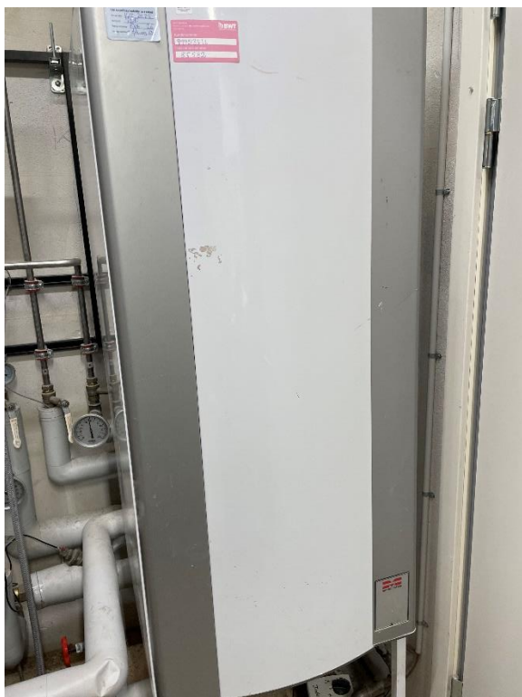
Varmtvandsbeholder
