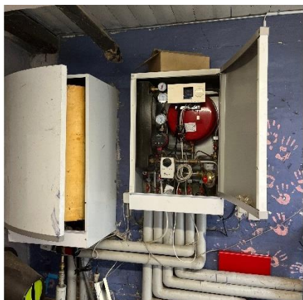
Fjernvarmeunit + ekstern varmtvandsbeholder
