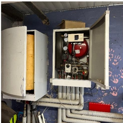
Fjernvarmeunit + ekstern varmtvandsbeholder
