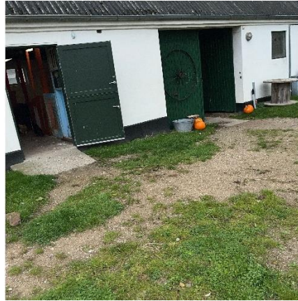
B2 Massiv isoleret, todelt yderdør i stald
