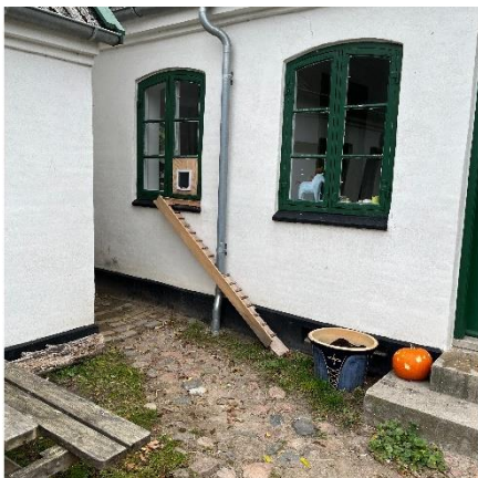
B1 Vinduer med etlag glas
