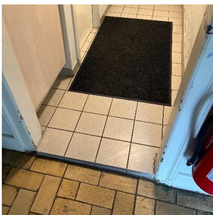
B2 Klinkegulve i gang og på toilet
